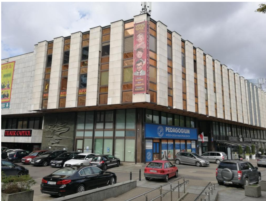
Dom Przyjaźni - 2019 (Teatr Capitol, „Pedagogium”, Restauracja „Si”) - od strony ulicy Marszałkowskiej.
